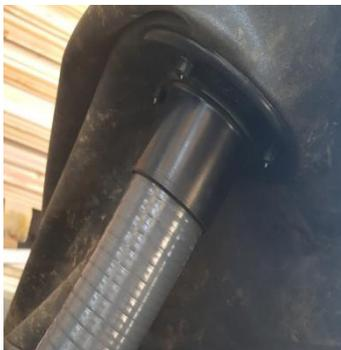
Coller le tube de la buse de refoulement au passage de paroi a l'aide de la colle EPDM livrée
