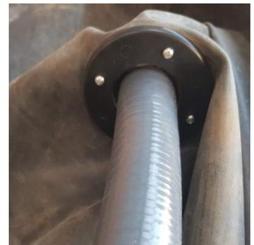
De l'autre coté du passage de paroi, coller le tube de la sortie de la filtration au passage de paroi a l'aide de la colle EPDM livrée
